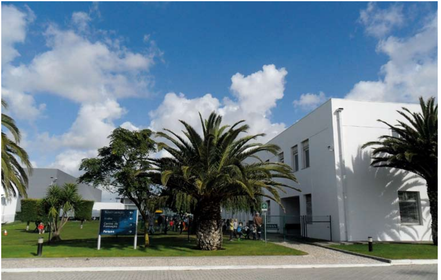
Die Unterkunft für die Bauzeit in Abrunheira bei Mercedes-Benz Portugal, S.A. O alojamento na Mercedes-Benz Portugal, S.A. na Abrunheira durante o período das obras.
