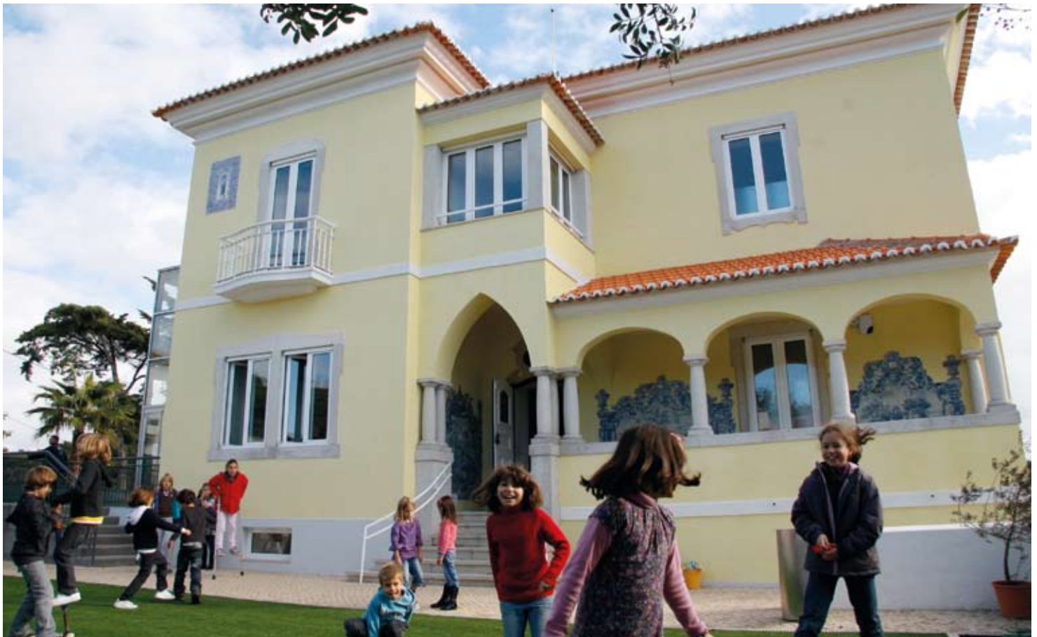
Die neue Schule in Estoril / A nova Escola no Estoril
